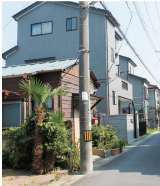
平屋の隣に3階建てが建っている
