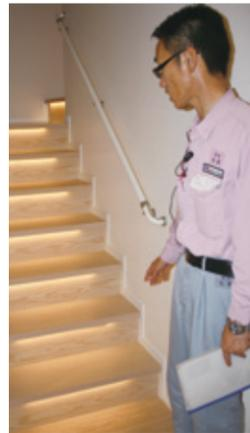
手すりのセンサーに触れると光が灯る階段
